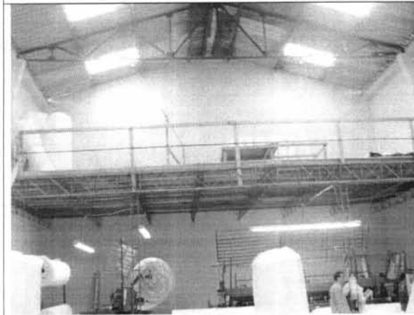
Foto 3. Aspecto general del interior de la edificación en el momento de la visita técnica.
