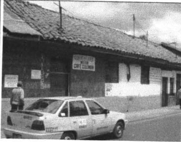
Foto 1. Fachada sobre la Carrera 7
