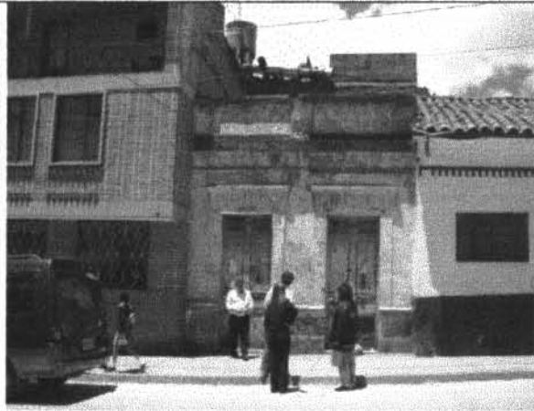
Foto 1. Fachada de la edificación
