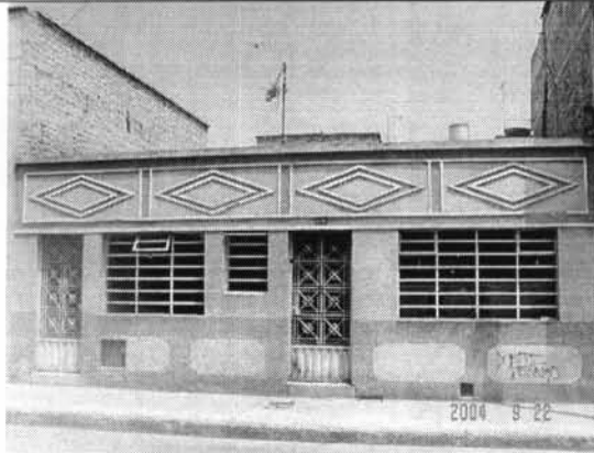
Foto 1. Fachada de la Edificación en las condiciones presentes al momento de la visita.
