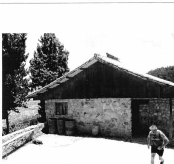
Foto 1. Fachada de la Edificación en las condiciones presentes al momento de la visita.
