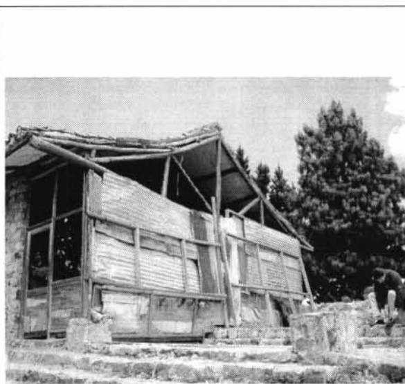
Foto 2. Costado Norte. Restos del desmonte de una estructura adosada.
