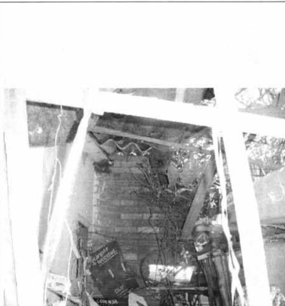
Foto 6. Muro con agrietamientos, el crecimiento de árboles y arbustos generan deterioro.
