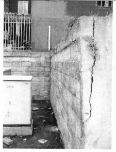
Foto 3. Muros de contención fracturados con pérdida de verticalidad
