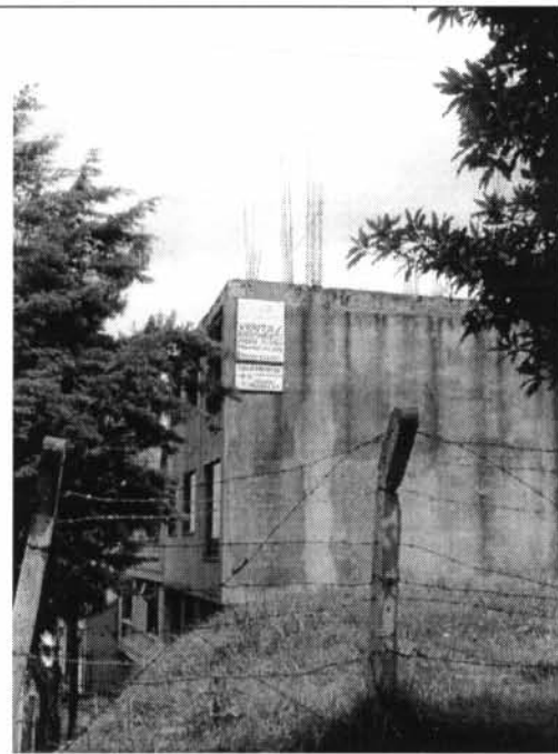
Foto 2. Vista lateral de la edificación, el acero de columnas indica que no se ha concluido la construcción.
