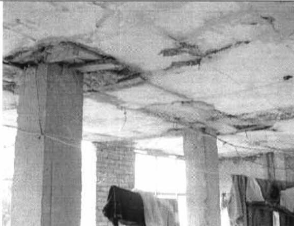
Foto 9. Unión de columnas con placa antigua en la parte anterior de la edificación.
