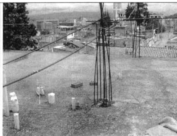
Foto 3. Vista placa superior parte posterior nueva, acero de prolongación de columnas.
