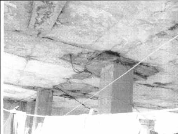
Foto 10. Unión del reforzamiento nuevo de columnas con la placa previamente existente.
