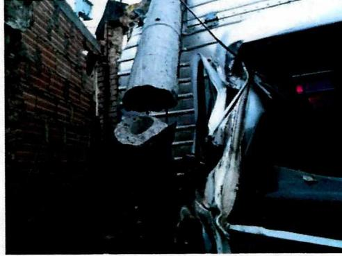
**Foto 4.** Fractura del poste de concreto que se encuentra contiguo a la fachada del predio de la Diagonal 17 B Sur # 11 - 04 Este.
