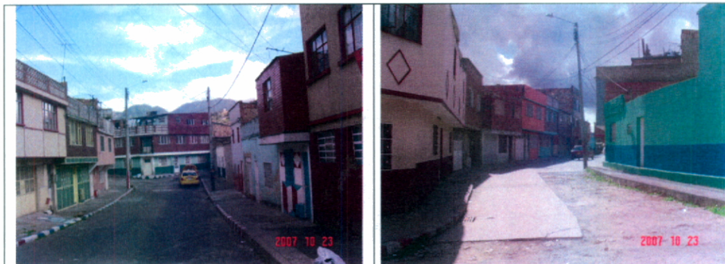
Fotografías No. 1 y No. 2 Aspecto de las vías en el desarrollo Gloria Gaitán II. Calle 45 Bis A Sur y Diagonal 45 Bis A Sur respectivamente.
