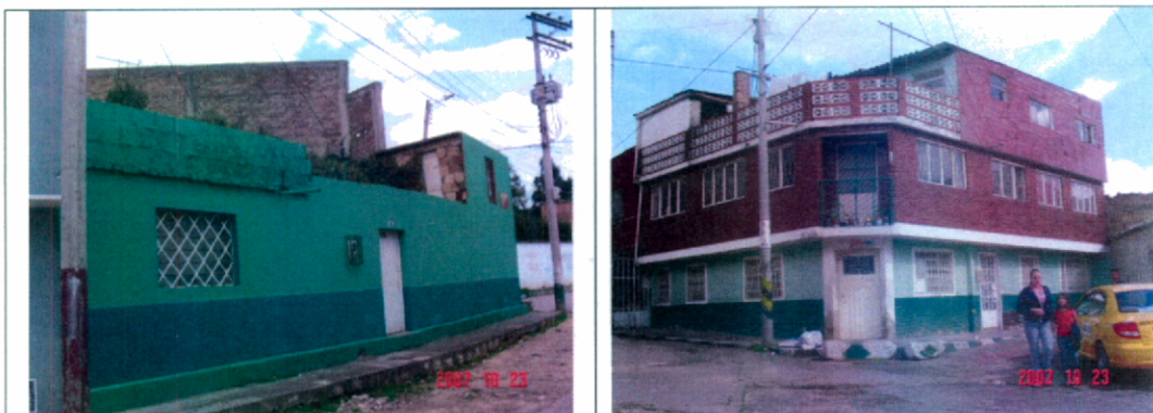
Fotografías No. 5 y No. 6. Tipología predominante de las viviendas en el desarrollo Gloria Gaitán II, que se caracteriza principalmente por viviendas en mampostería sin confinamiento estructural.
