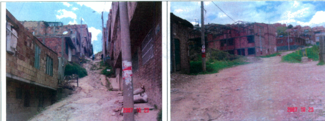
Fotografías No. 1 y No. 2 Aspecto de las vías sin pavimentar en el desarrollo La Arboleda Sur II. Diagonal 48A Bis A Sur y Carrera 5K Bis respectivamente.
