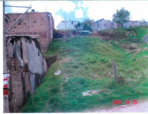
Fotografía No. 4. Talud de corte realizado para la implantación de las viviendas en la parte sur del desarrollo La Arboleda Sur II.
