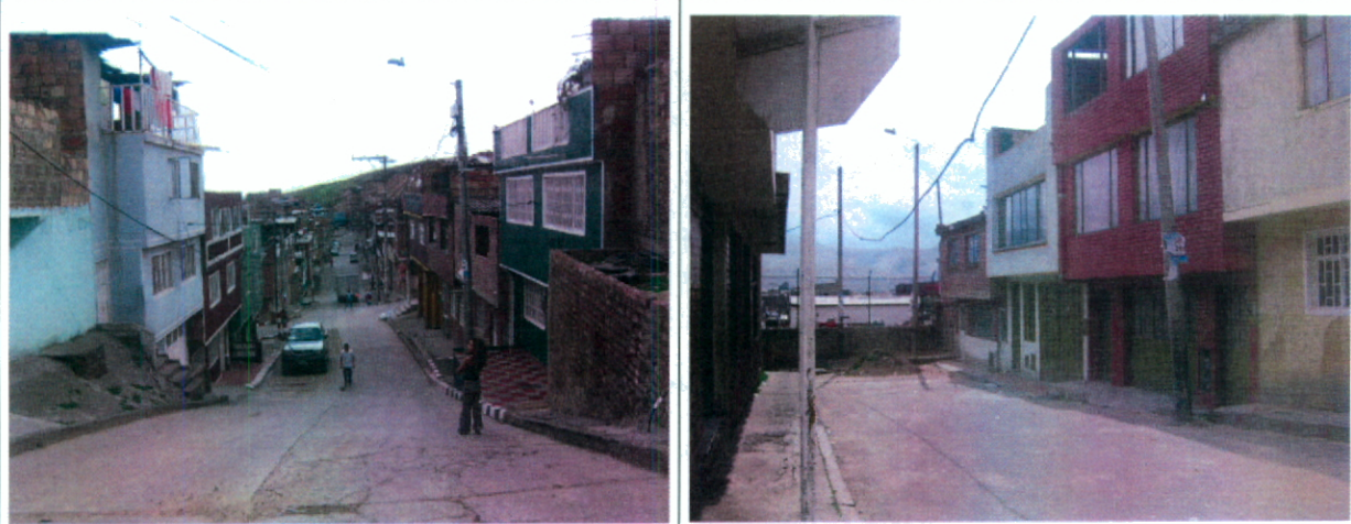
Fotografías No. 1 y No. 2 Aspecto de las vías pavimentadas dentro del desarrollo El Socorro IV. Calle 50 B Sur y Diagonal 49 D Sur respectivamente.
