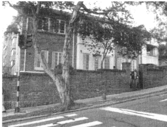
Foto No. 1. Aspecto del predio donde se construirá el proyecto de la CALLE 75 # 4 – 74
