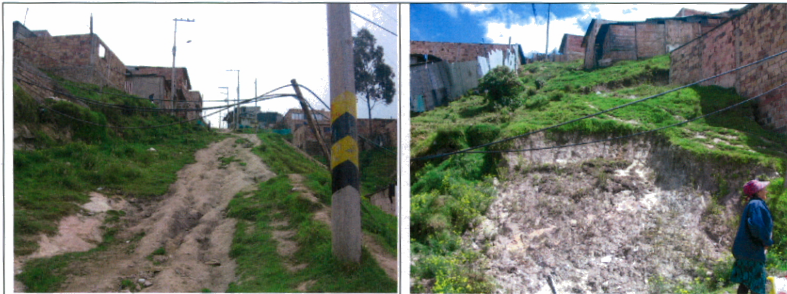
Fotografías No. 3 y No. 4. Aspecto de las vías sin estructura de pavimento en el desarrollo San Martín. Nótese en la Fotografía No. 3, el desarrollo de procesos de erosión laminar y en pequeños surcos favorecido por el aumento de la pendiente.
