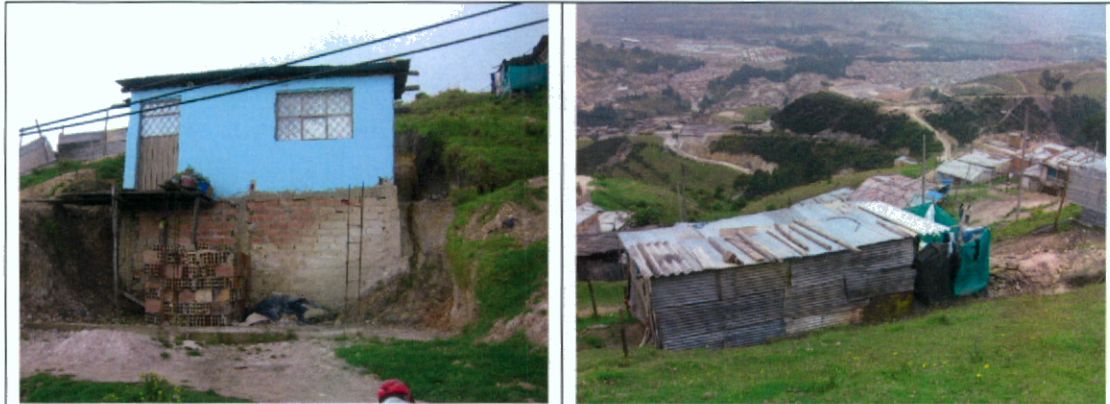
Fotografías No. 5 y No. 6. Tipología predominante de las viviendas en el desarrollo San Martín, que se caracteriza por construcciones principalmente en mampostería sin confinamiento, con condiciones estructurales regulares y viviendas construidas con materiales de recuperación respectivamente.
