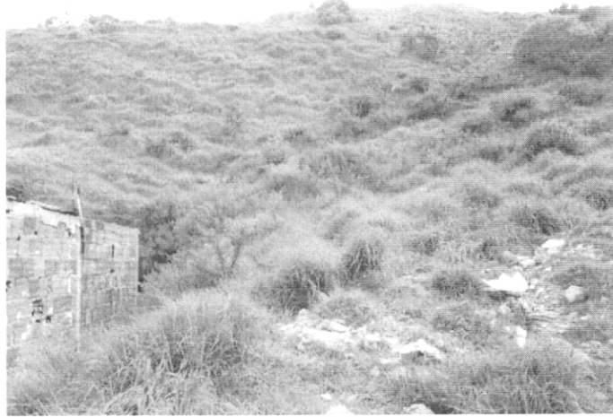
Fotografía No. 3 Aspecto del sector nor oriental del desarrollo, donde se observa la presencia de rellenos antrópicos, dispuestos sin ningún control técnico y cuyo espesor se desconoce.
