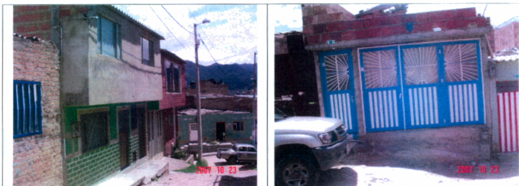
Fotografías No. 4 y No. 5. Tipología predominante de las viviendas en el desarrollo Villa Gladys I, que se caracteriza principalmente por viviendas en mampostería con y sin confinamiento estructural.
