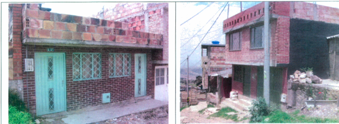
Fotografías No. 3. Tipología predominante de las viviendas en el desarrollo Buenavista II Sector, que se caracteriza por viviendas en mampostería sin y con confinamiento estructural respectivamente.
