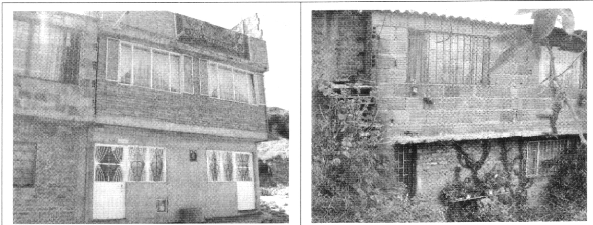
Fotografías No. 11 y No. 12. Tipología predominante de las viviendas en el desarrollo, que se caracteriza por viviendas en mampostería con condiciones estructurales que se pueden considerar como regulares.
