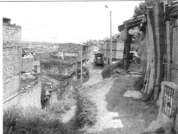
Fotografía No. 8 Ausencia de cunetas sobre un sector de la CI 49 G Sur.
