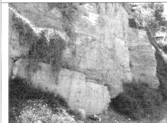
Fotografía No. 4 Talud de arenisca localizado sobre la Cl 49 G Sur.
