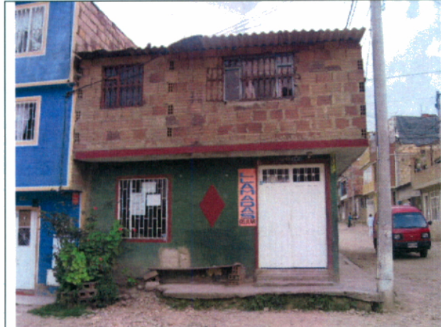
Fotografía No. 8 Tipología predominante de las viviendas en el desarrollo, que se caracteriza por construcciones principalmente en mampostería sin confinamiento y con condiciones estructurales regulares.
