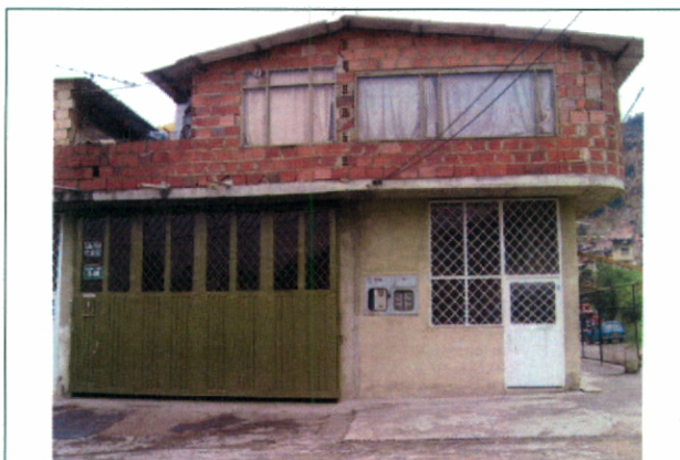
Fotografía No. 8 Tipología predominante de las viviendas en el desarrollo, que se caracteriza por construcciones principalmente en mampostería sin confinamiento y con condiciones estructurales regulares.
