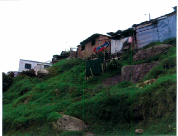
Fotografía No. 3. Se aprecian bloques de arenisca que son potencialmente inestables y pueden afectar los predios del desarrollo SAN JOSÉ DE LOS SAUCES y definen una condición de alta susceptibilidad a la generación de fenómenos de remoción en masa
