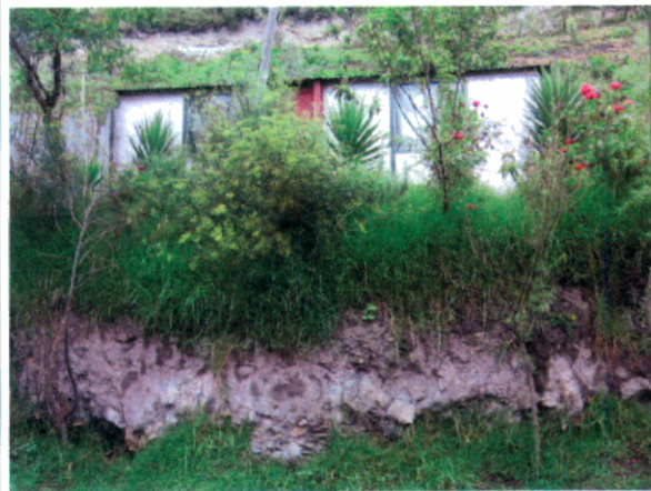
Fotografía No. 4. Vivienda construida en la parte baja de una ladera de alta pendiente sobre depósitos poco consolidados de origen coluvial.
