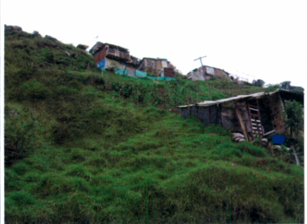
Fotografía No. 5. Sector nororiental del desarrollo SAN JOSÉ DE LOS SAUCES, donde se han implantado algunas viviendas que se encuentran sobre una ladera de pendiente alta a muy alta.
