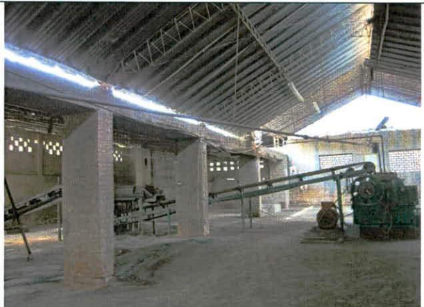
Foto 18. Pórtico eje central zona de la extrusora.
