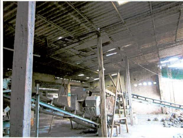
Foto 31. Postes de madera cubierta en teja de fibrocemento.
