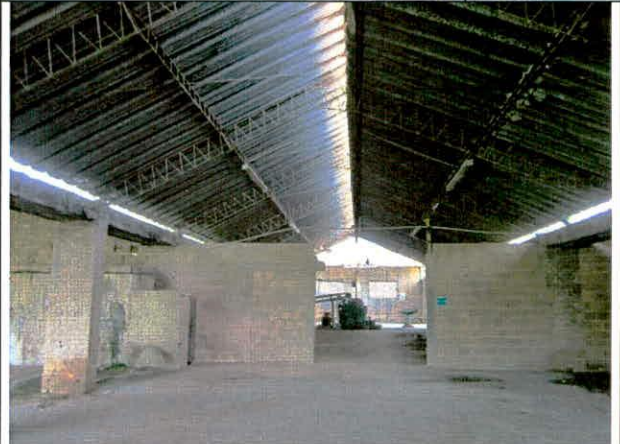
Foto 12. Aspecto interno de la nave industrial oriental.
