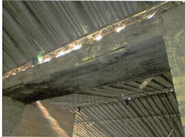
Foto 15. Placa de concreto de la canal sin daño.
