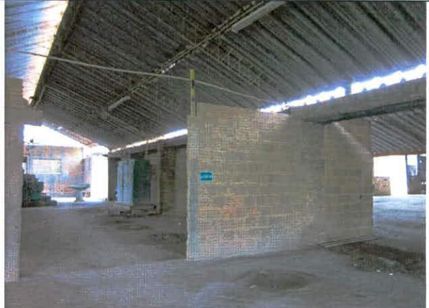
Foto 16. Muros internos del sector medio sin daño visible.
