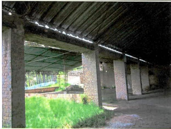
Foto 13. Pórtico en buenas condiciones.
