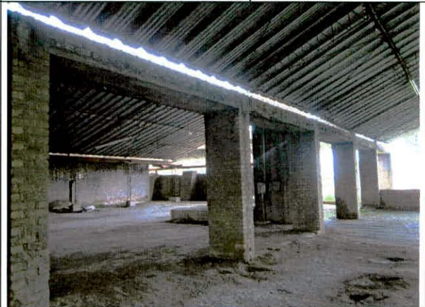
Foto 10. Pórticos de machones de mampostería.
