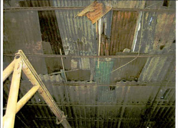
Foto 34. Reparaciones y reemplazo de tejas.
