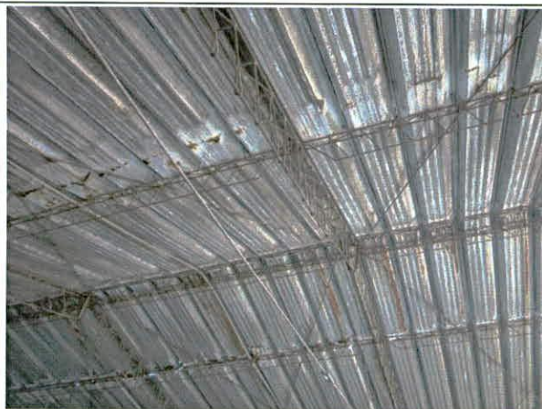
Foto 5. Vigas, tensores y contravientos en buen estado.
