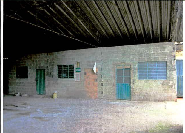
Foto 8. Muros internos en bloque en buen estado.
