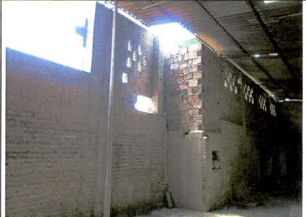
Foto 24. Muros en ladrillo y bloque del costado oriental.
