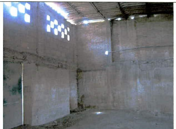
Foto 26. Adición de muros de varias etapas de construcción.
