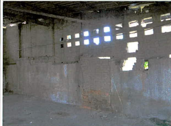
Foto 23. Deterioro generalizado de los muros perimetrales.
