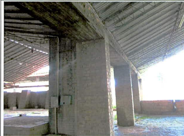
Foto 11. Pórticos de machones de ladrillo y canal.
