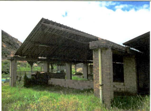
Foto 14. Nave oriental sin evidencia de daño.
