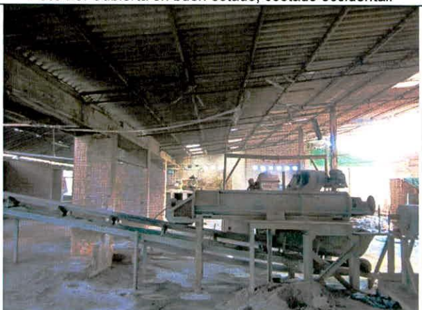
Foto 30. Cubierta del costado oriental en zona de extrusora.
