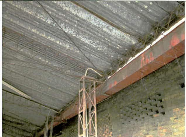
Foto 2. Elementos en buen estado estructural.
