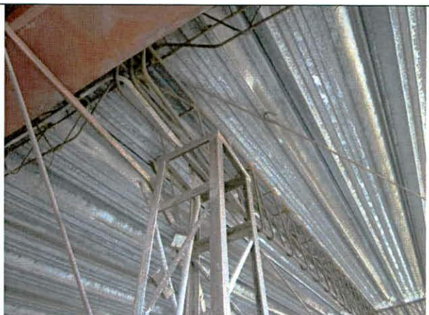
Foto 6. No se detectan daños en las uniones.
