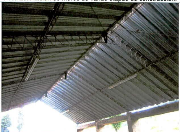
Foto 28. Cubierta en buen estado, costado occidental.
