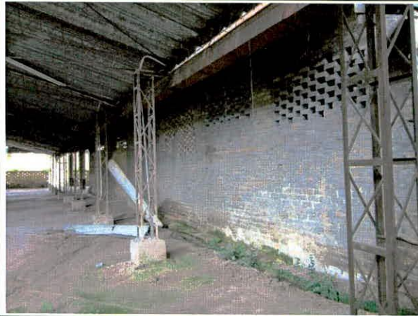
Foto 1. Eje o hilera de columnas metálicas.
