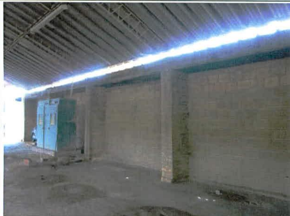
Foto 17. Machones y muros en buen estado estructural.
