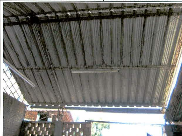
Foto 29. Canaletas sin evidencia de daños.
