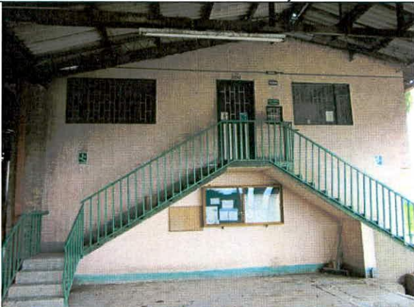
Foto 20. Muros externos en buenas condiciones.
