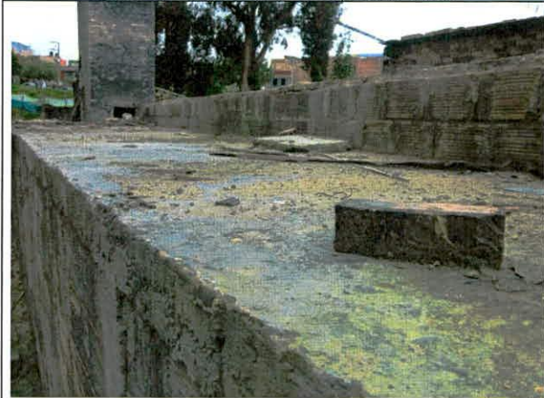
Foto 9. Aspecto de la placa de cubierta, costado oriental.
