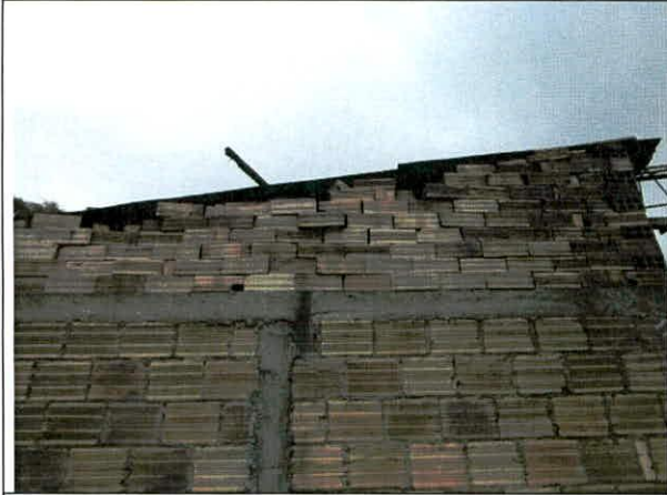
Foto 17. Bloques sueltos para conformar la cuchilla.
