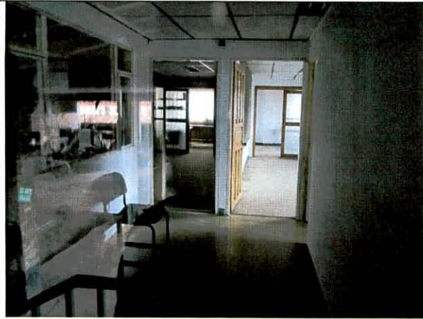
Foto 23. No se detecta daño en los elementos internos.
