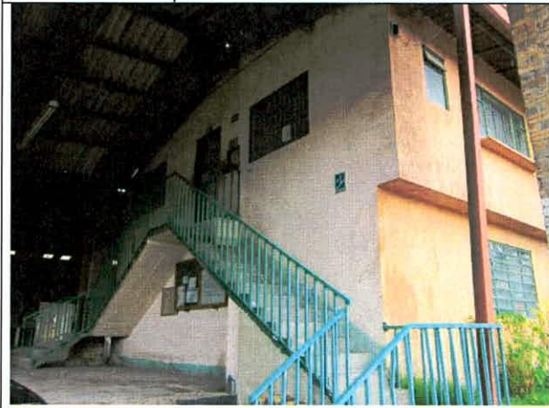
Foto 21. No se detectan daños en los muros externos.
