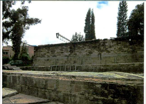
Foto 10. Muros en mampostería y demoliciones parciales.
