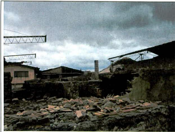
Foto 11. Demoliciones parciales de los muros.
