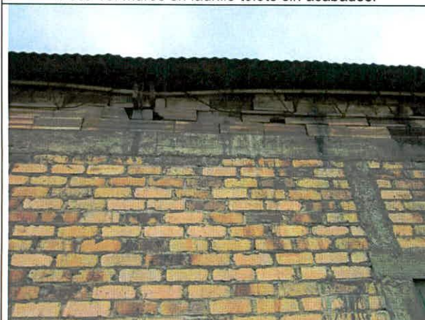
Foto 15. Elementos de confinamiento en concreto.
