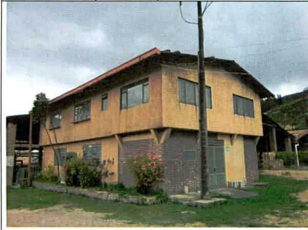
Foto 19. Aspecto externo de la casa de oficinas.
