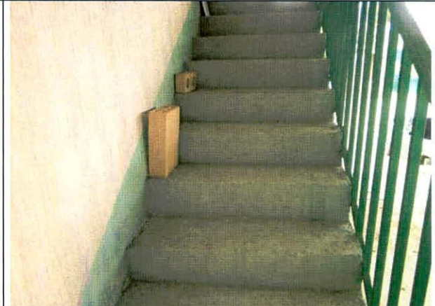
Foto 26. Escalera en buen estado, sin daño visible.
