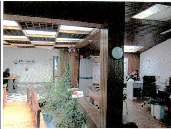
Foto 7. Vista general interna, no se detecta daño estructural.
