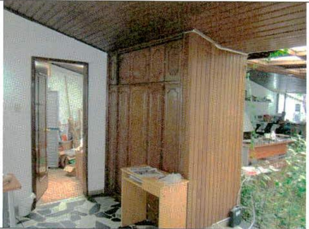
Foto 8. Muros internos en buen estado.
