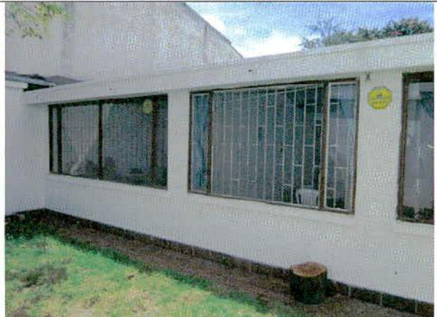
Foto 14. Muros del sector posterior sin daño.
