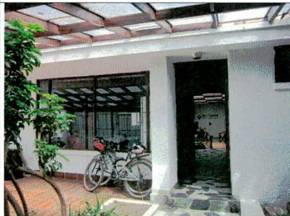
Foto 5. No se detecta daño en la fachada interna.
