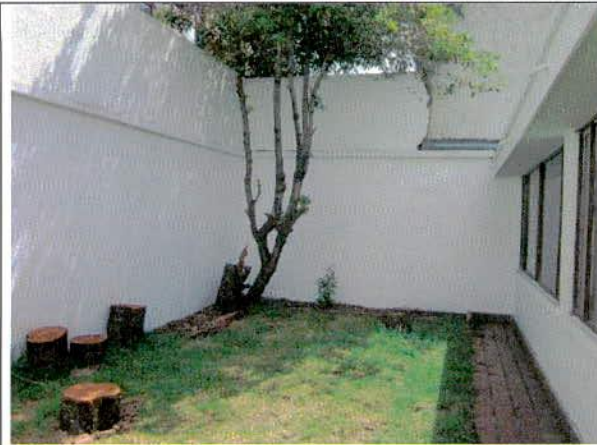
Foto 13. Muros perimetrales del patio en buen estado.
