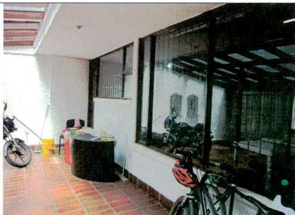
Foto 6. Elementos sin evidencias de daños.
