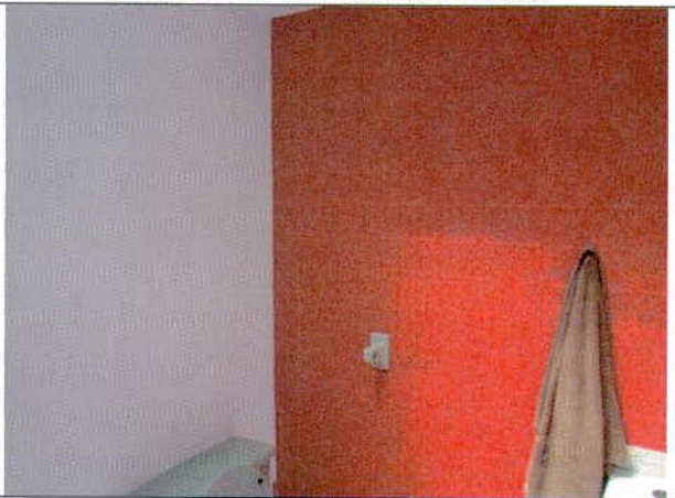
Foto 10. Muros internos y acabados sin daño.
