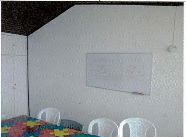
Foto 12. Muros internos sin daño estructural visible.
