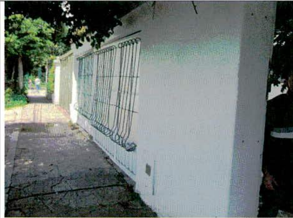
Foto 3. Muros externos sin evidencia de daño estructural.
