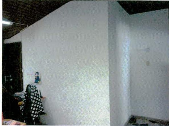
Foto 9. No se detectan daños en los muros del inmueble.
