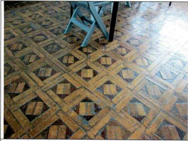
Foto 19. Placa de contrapiso sin daño visible.
