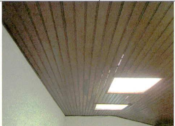
Foto 16. Cielo raso en madera en buenas condiciones.
