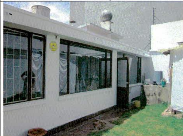
Foto 15. Fachada en patio posterior sin evidencia de daños.
