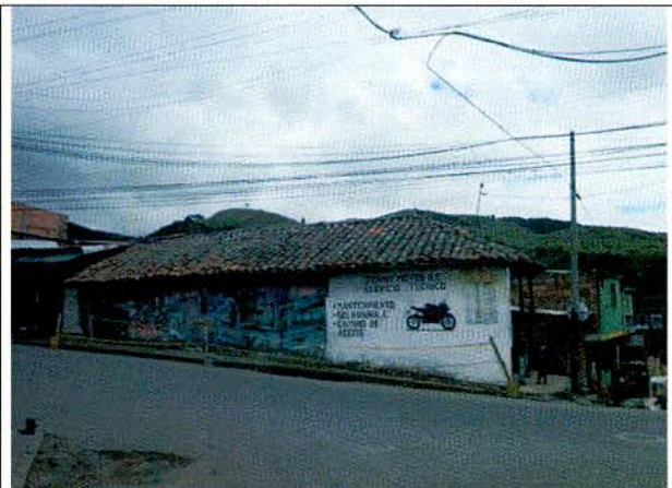
Foto 2. Fachada sur sobre la Carrera 14.
