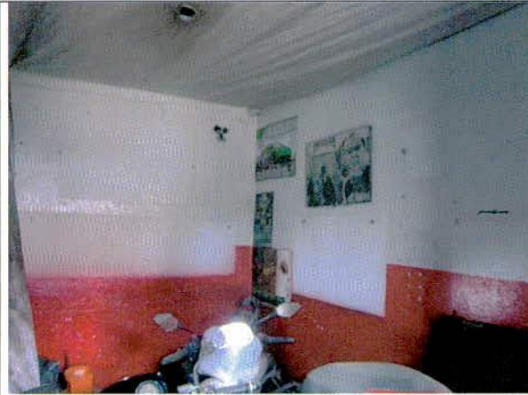
Foto 11. Muros internos de la zona del local comercial.
