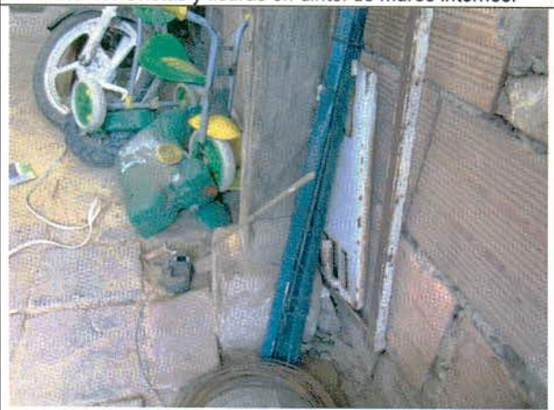
Foto 19. Apoyo de los postes de madera del alero.
