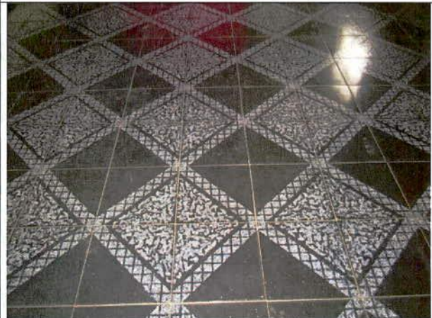
Foto 30. Placa de piso sin afectaciones visibles.
