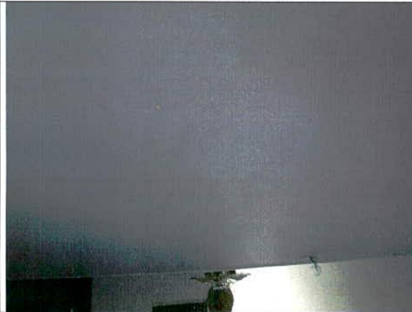
Foto 29. Cielo raso bajo cubierta en buenas condiciones.
