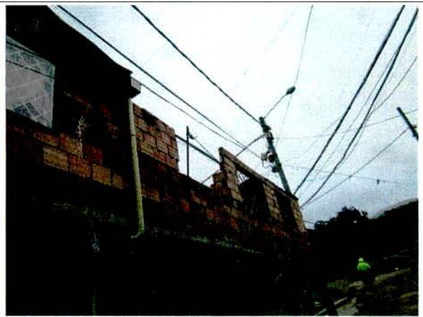
Foto 4. Muro de fachada del costado sur extremo oriental.
