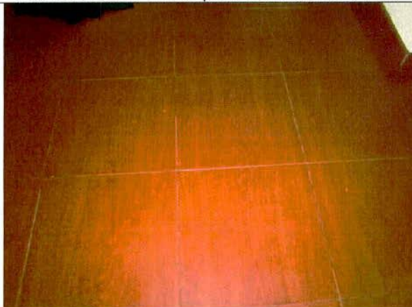
Foto 25. Acabados de entrepiso en buen estado.
