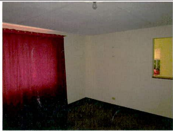
Foto 16. Buen estado de los muros internos de primer piso.
