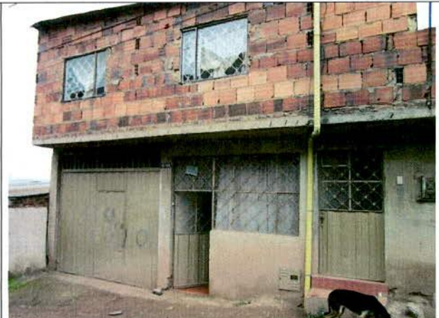
Foto 2. Fachada del costado sur extremo occidental.
