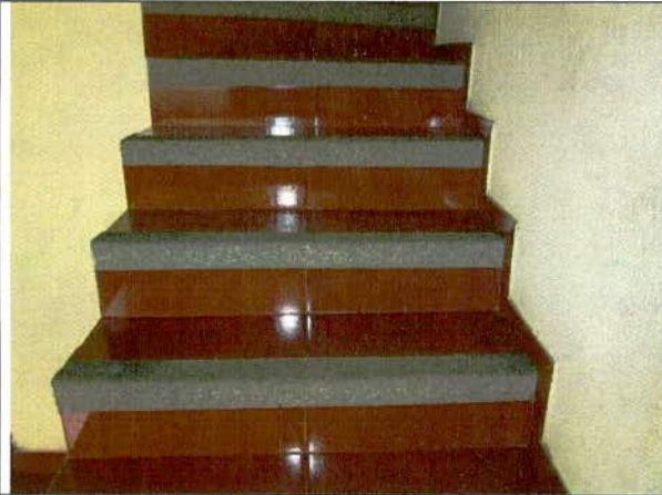
Foto 27. Escaleras sin daño estructural visible.
