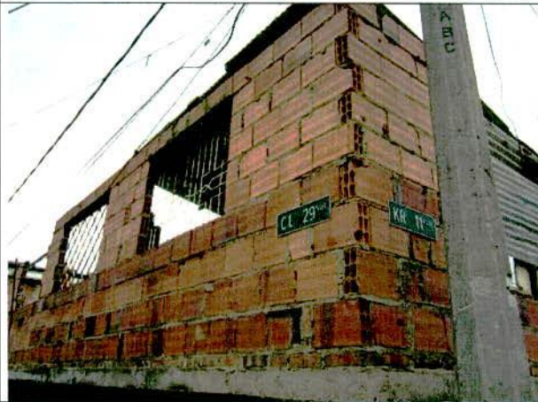
Foto 5. Esquina suroriental de la fachada de segundo nivel.
