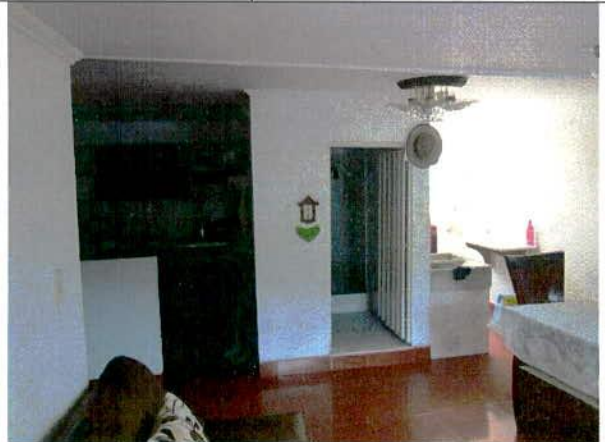
Foto 19. Elementos internos de segundo piso sin daño.
