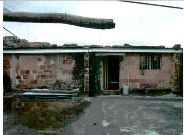
Foto 22. Muro de segundo piso, salida a la azotea.
