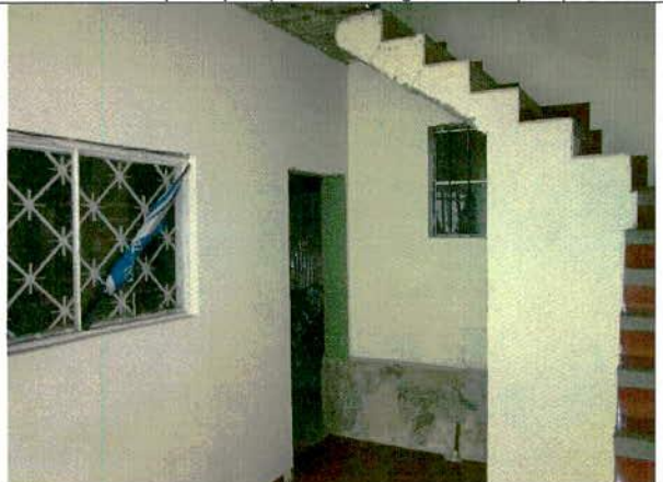
Foto 14. Muros internos de primer piso en buen estado.
