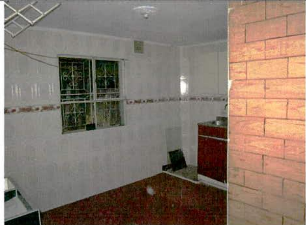
Foto 18. Muros y sus acabados en buenas condiciones.
