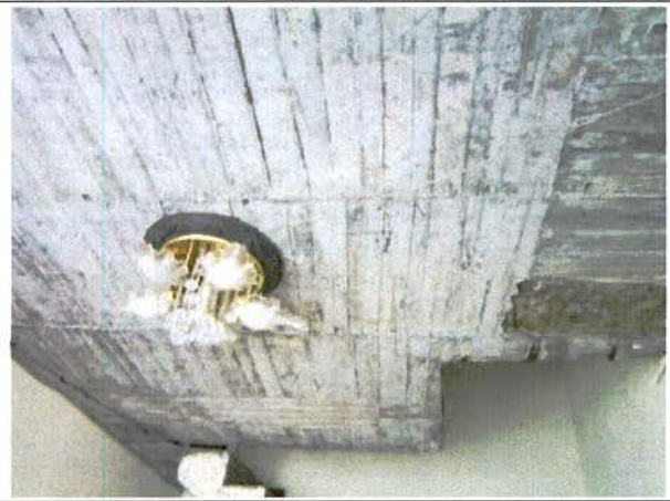
Foto 24. Placa de entrepiso en buenas condiciones.
