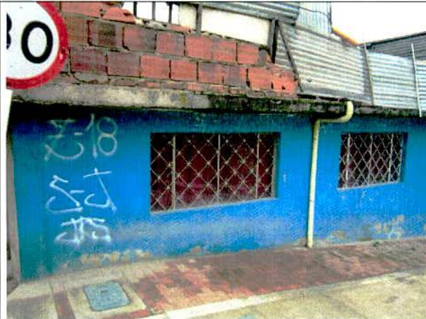
Foto 3. Fachada del costado oriental, primer piso.
