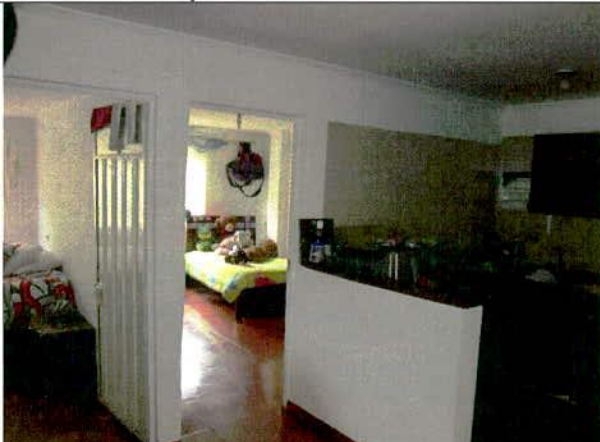
Foto 20. No se evidencia daño en muros de segundo nivel.
