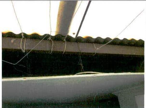
Foto 28. Cubierta liviana sin evidencia de daño.
