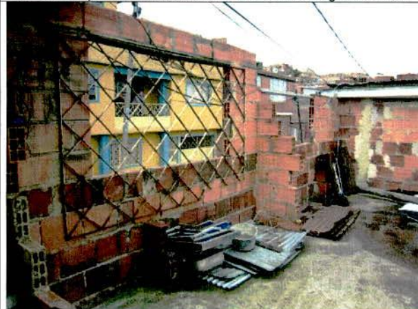
Foto 7. Muro de fachada del costado sur en la azotea.
