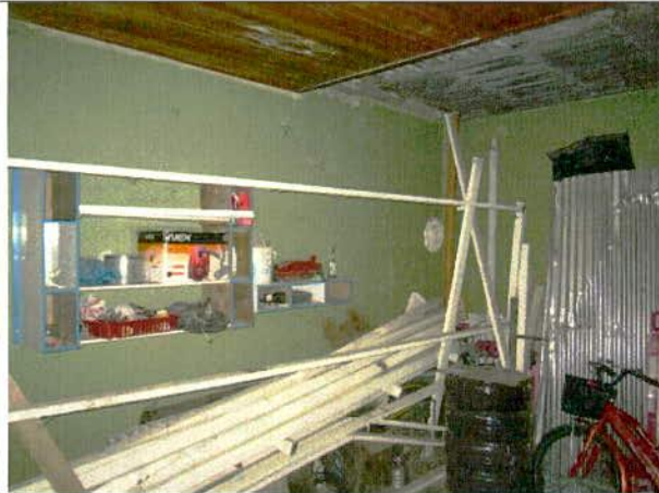
Foto 15. Muros internos sin evidencia da daño estructural.
