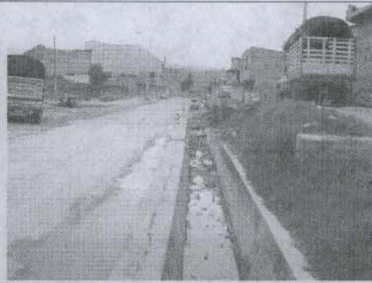
Fotografía 4. Obstrucción por escombros de construcción en el canal longitudinal a la Avenida Diagonal 60 Sur, a la altura del desarrollo Maria Cano
