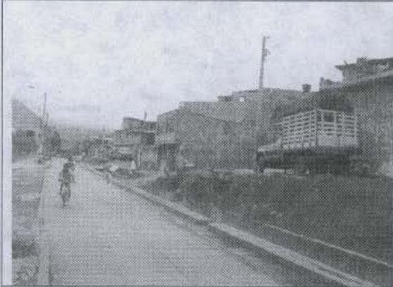
Fotografía 3. Canal longitudinal a la Avenida Diagonal 60 Sur, a la altura del desarrollo Maria Cano, donde constituye el eje principal del drenaje de la escorrentía superficial en el sector
