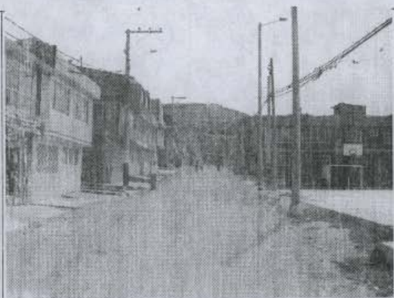
Fotografía 2. Zona de topografía plana hacia el sector central del desarrollo, conformada por un substrato de rocas arcillosas superpuestas por rellenos antrópicos de explanación.
