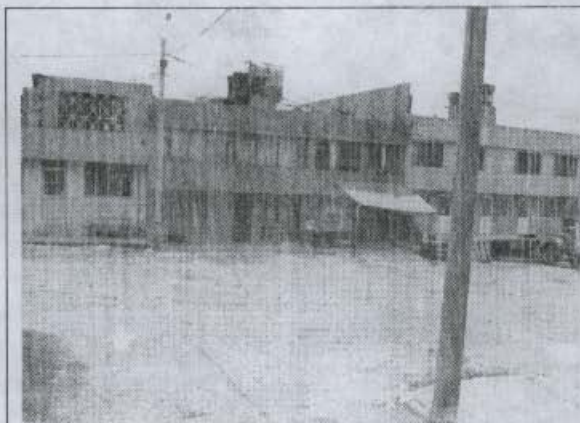
Fotografía No. 6. Tipología predominante de las viviendas en el desarrollo, que se caracteriza por viviendas en mampostería con confinamiento estructural, con condiciones estructurales regulares y buenas.
