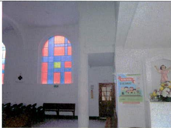
Foto 13. Elementos estructurales del costado norte.
