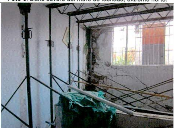
Foto 8. Cara interna del primer piso de la fachada.
