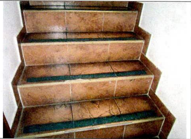
Foto 28. Escaleras en buenas condiciones.
