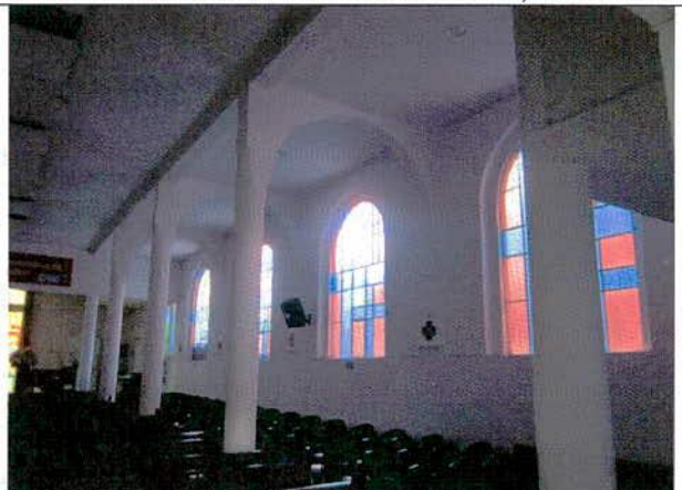
Foto 14. No se detecta daño en la zona del templo.
