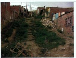
Fotografía 13. Procesos de erosión laminar a lo largo de los accesos del desarrollo Caracolí desprovistos de obras de drenaje y de pavimentación.
