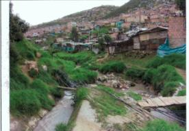
Fotografía 15. Disposición de residuos sólidos sobre el Zanjón "La Muralla", lo que indica el grave deterioro en que se encuentra y su alta intervención antrópica que se traduce en cambios en sus condiciones hidráulicas y la afectación de las zonas aledañas por donde discurre.
