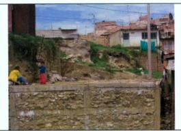
Fotografía 12. Aspecto de la estructura en piedra pegada utilizada para confinar algunos rellenos colocados en el desarrollo, pero que carecen de drenaje.
