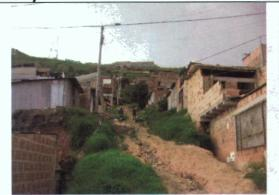
Fotografía 14. Procesos de erosión en surcos que afectan los accesos del desarrollo Caracolí desprovistos de obras de drenaje y de pavimentación.
