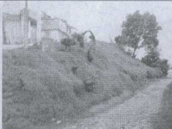
Fotografía 4. Ladera sobre suelo residual hacia el costado sur del desarrollo Tuna Alta Sector El Bosque, donde se evidencian procesos de reptación acentuados por las condiciones de pendiente alta.
