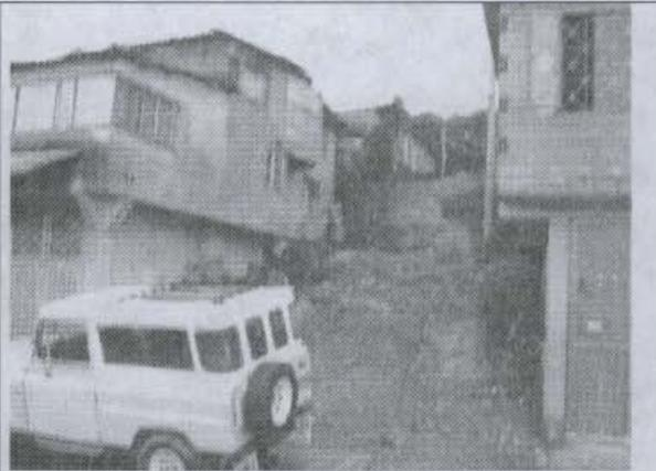
Fotografía 5. Procesos de erosión laminar y en surcos a lo largo de las vías desprovistas de pavimentación en el sector sur del Barrio tuna Alta Sector El Bosque. Se evidencia la acción de la escorrentía superficial sobre el terreno.
