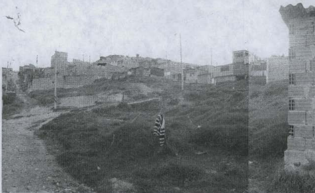
Fotografía 7. Aspecto general del desarrollo Bogotá II Sector, donde se observa la presencia tanto de geoformas planas, como la presencia de laderas inclinadas de pendiente moderada donde se observan procesos de erosión laminar y en surcos..
