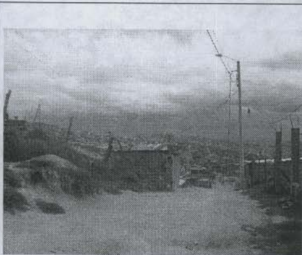
Fotografía 5. Aspecto de las zonas verdes y las vías del desarrollo, las cuales presentan procesos marcados de erosión por acción de la escorrentía superficial sobre el terreno, los cuales pueden evolucionar generando procesos de remoción en masa en las zonas del desarrollo de mayor pendiente.
