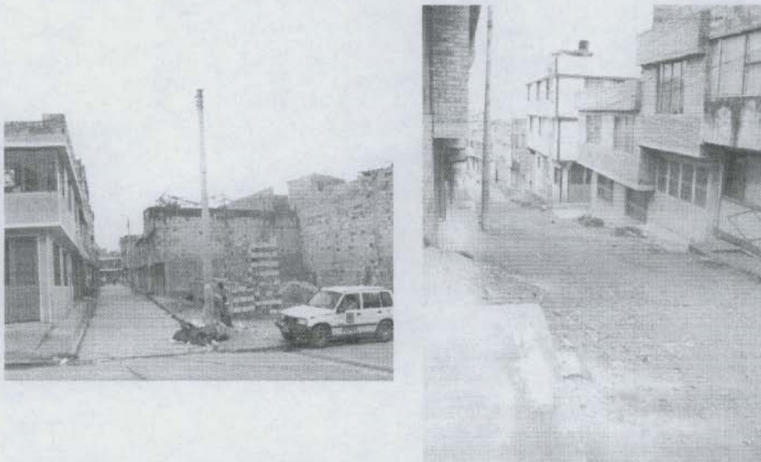
Fotografías N° 3 y N° 4. Aspecto general de las vías del barrio donde se presentan vías pavimentadas como sin pavimentada y donde se desarrollan procesos erosivos superficiales.
