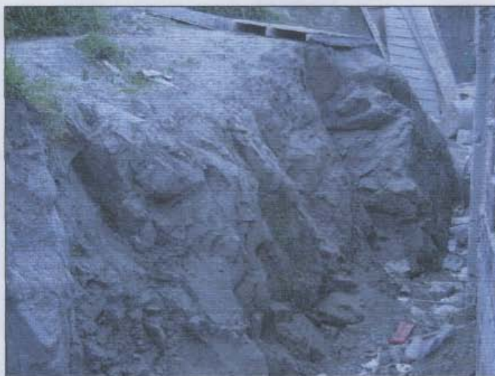
Fotografía 7. Detalle de un talud de corte en rocas de la Formación Bogotá, al costado Este del barrio Ramírez.
