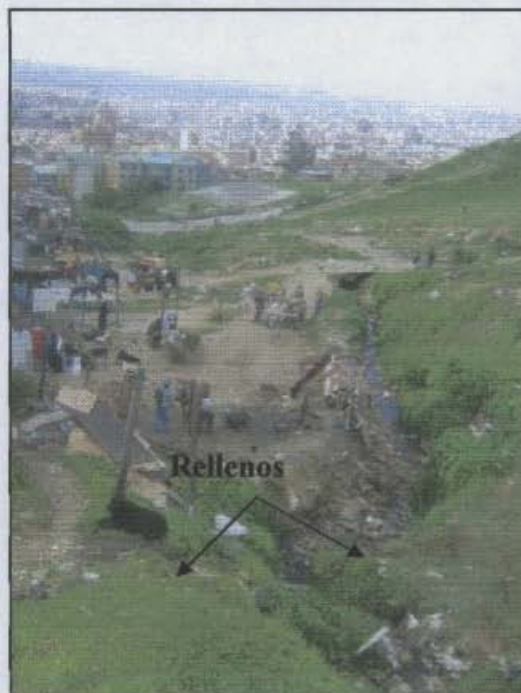
Fotografía 3. Detalle de los rellenos en ambas márgenes de la quebrada Las Lajas hacia la parte norte del barrio Ramírez.
