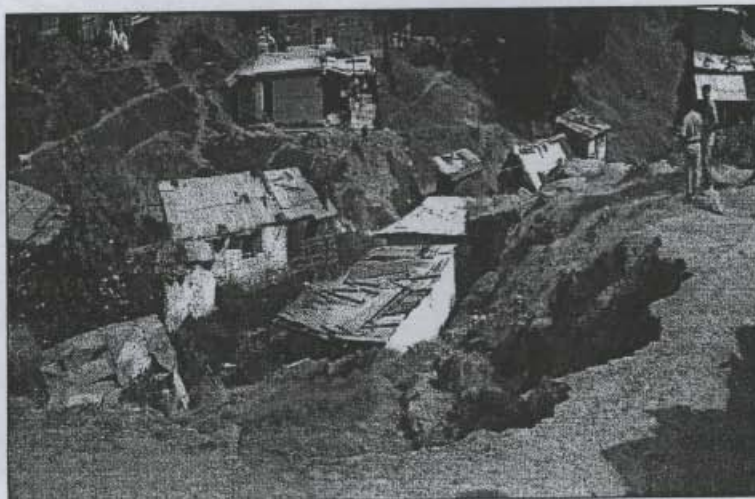
Fotografía 12. En la fotografía se registra un deslizamiento en el barrio Buenos Aires II en una de las márgenes de la quebrada El Infierno.
