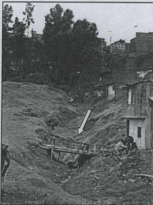
Fotografía 10. Flujo de tierra en el cauce de la quebrada el infierno, barrio Buenos Aires II
