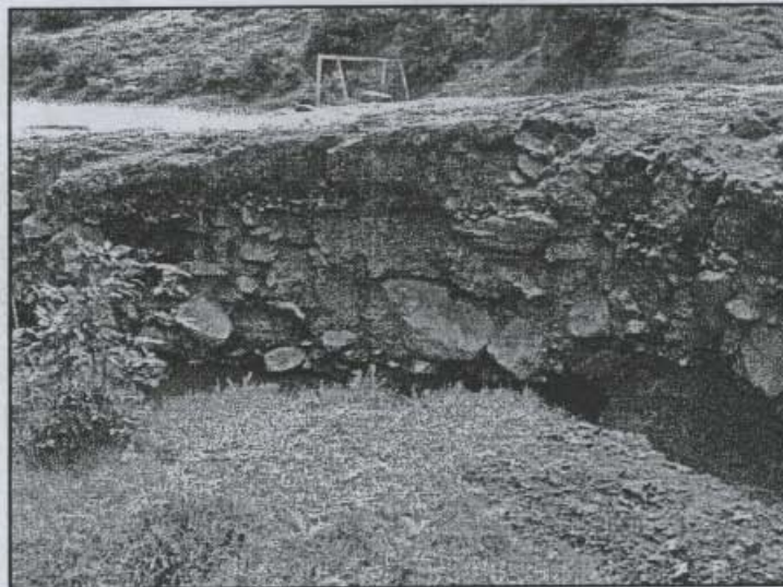
Fotografía 5. Detalle del depósito aluvial en la margen izquierda de la quebrada El Infierno en el barrio Buenos Aires II.
