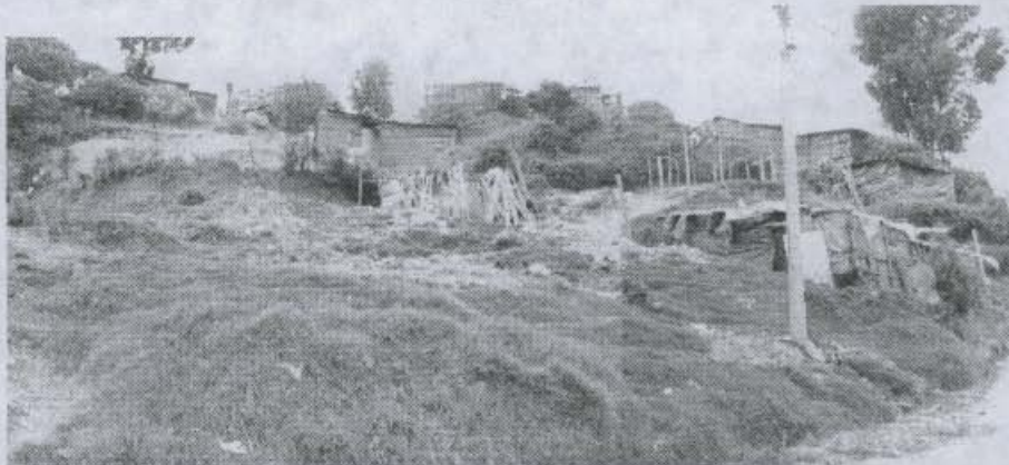
Fotografía 4. Proceso de inestabilidad complejo, afectando el borde oriental del desarrollo Triángulo Alto y el borde occidental del desarrollo Manantial.
