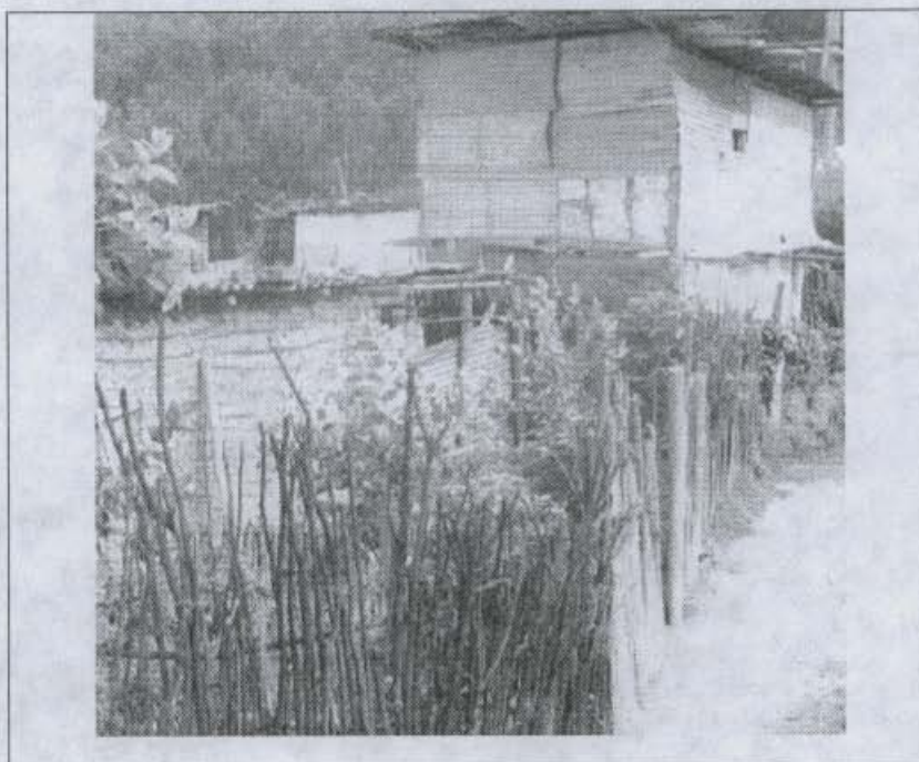
Fotografía 5. Se aprecia la vivienda en material de recuperación de 2 pisos y una vivienda que evidencia las técnicas constructivas deficientes.
