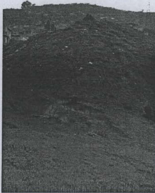
Fotografía 5. Detalle del relleno existente por fuera del perímetro del barrio Tesoro II, que se puede tomar inestable, pudiendo incidir en la estabilidad del barrio y del sector en general.
