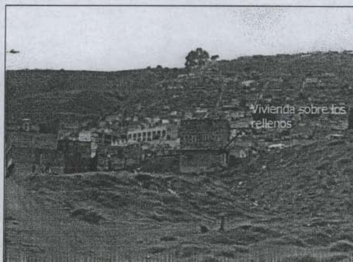
Fotografía 3. Panorámica donde se indica la vivienda cimentada sobre rellenos en el cauce del drenaje natural, barrio Tesoro II.
