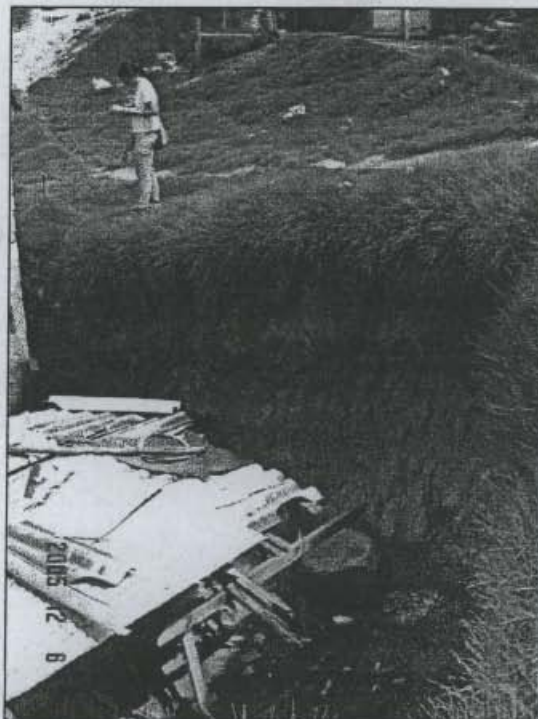
Fotografía 7. Talud de corte para la construcción de viviendas, barrio Villa Anita III Sector.
