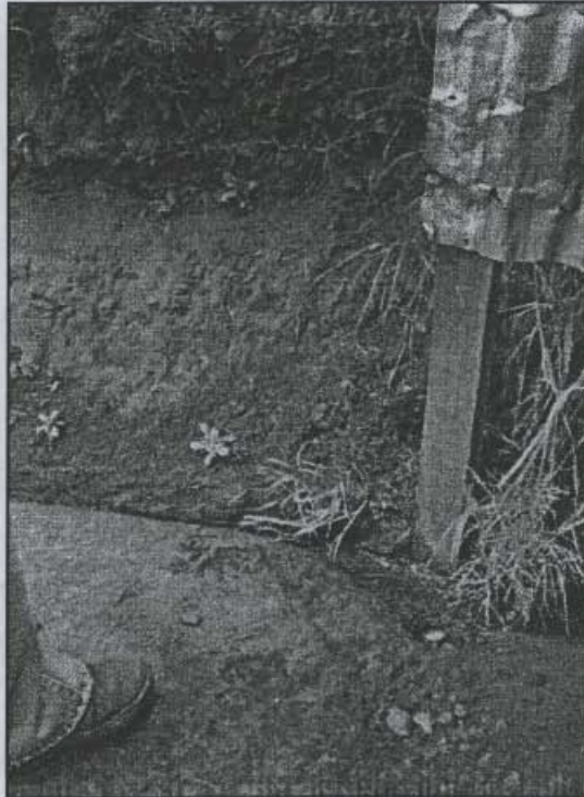
Fotografía 4. Suelos negros con un espesor aproximado 1m, tomado en un talud de corte en el barrio Villa Anita III Sector.
