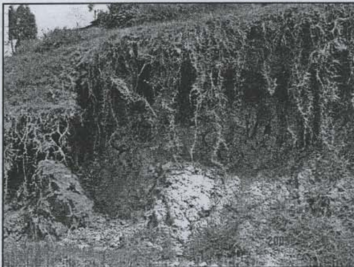
Fotografía 3. Suelo arcillosos correspondientes a la matriz del depósito fluvioglacial en el barrio Villa Anita III Sector.
