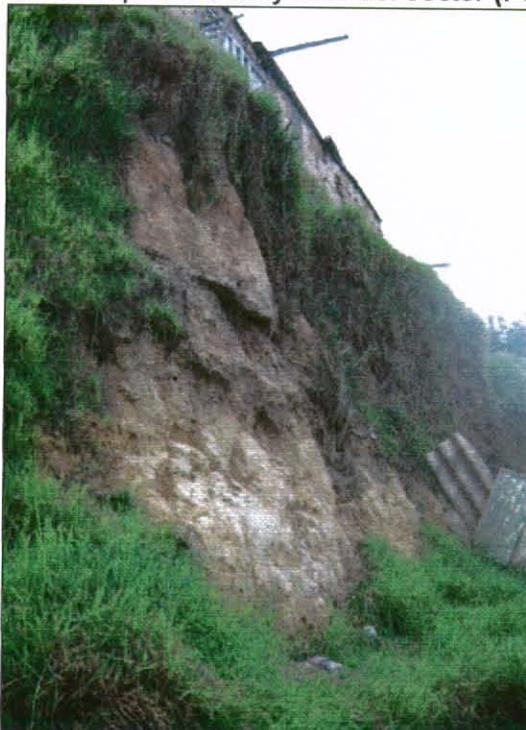
**Fotografía 3.** Talud de corte donde afloran rocas blandas (arcillolitas) y duras (areniscas) de la formación Regadera. En la parte superior se observa el estrato de suelo residual típico de esta formación
