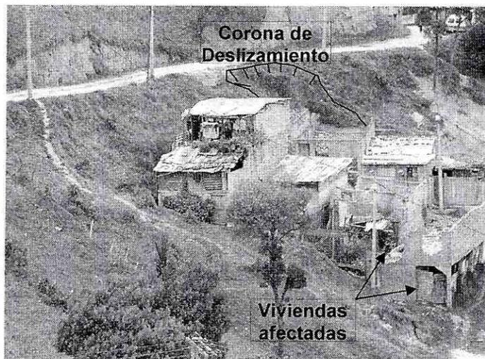
Fotografía N° 3. Detalle de un deslizamiento superficial en la zona de alta amenaza (Manzana A).
