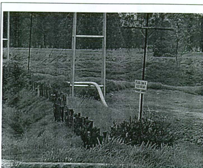
Foto No. 3. Línea del poliducto Mancilla - Puente Aranda
