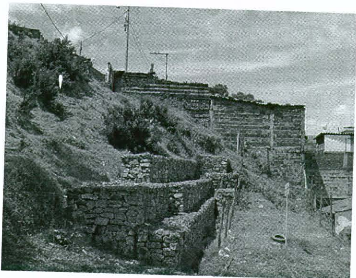
Fotografía No.1. Predios en alta amenaza, sobre la Transversal 12 Este con Calle 28 Sur
