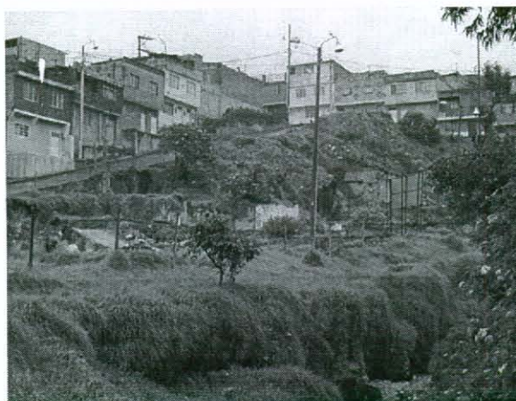
Fotografía No. 1. Panorámica de los procesos de inestabilidad de las márgenes de la quebrada Chiguaza
