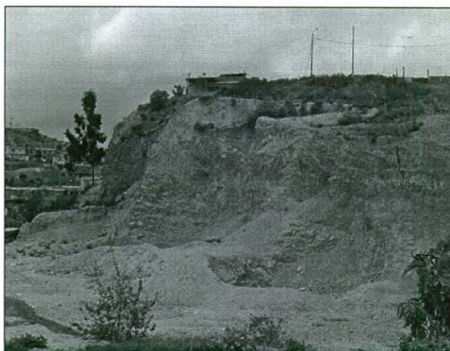
Fotografía 1. Escarpe de explotación, en la corona del mismo se localiza la vivienda 03
