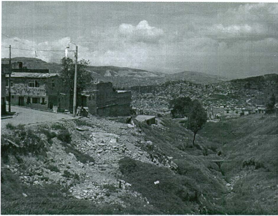
Fotografía 1. Muestra proceso de socavación en la quebrada Chorro Colorado y los predios reubicados
