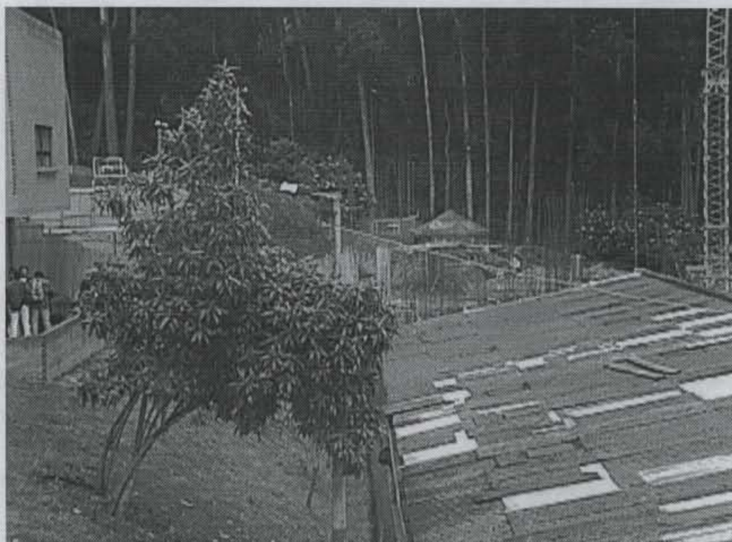
Fotografía No. 4. Extremo occidental del "globo B". Al fondo de la fotografía se aprecia la construcción adelantada en el sector.
