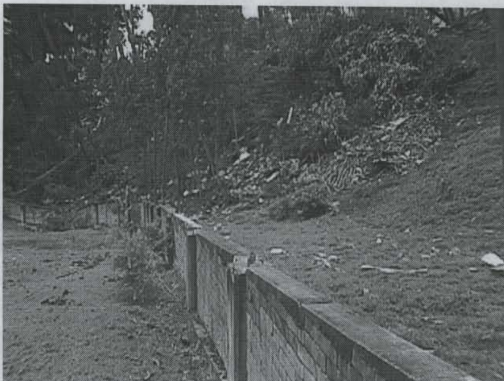
Fotografía No. 3. Límite nororiental de la Universidad Distrital. Se observa la disposición inadecuada en predios externos a la universidad de material de diversos orígenes en la ladera de más alta pendiente.
