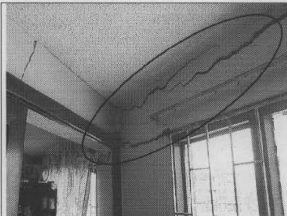
Foto 5. Continuidad de las grietas en el costado occidental del inmueble, sector voladizo.
