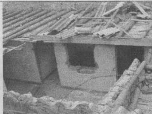
Foto 2. Estructura parcialmente demolida.
