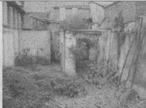
Foto 2. Estructura parcialmente demolida.
