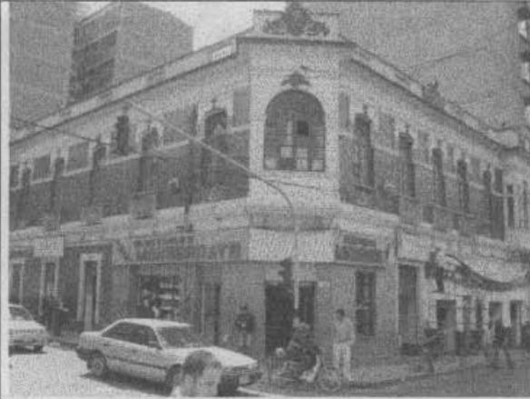
Foto 1. Fachada de la edificación
