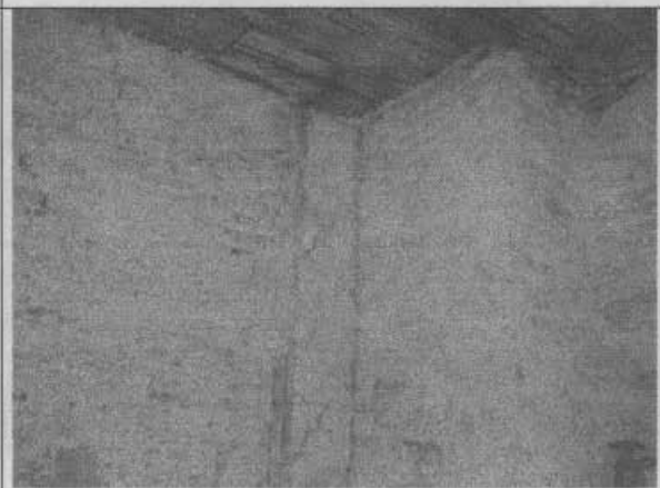
Foto 8. Muros fisurados.
