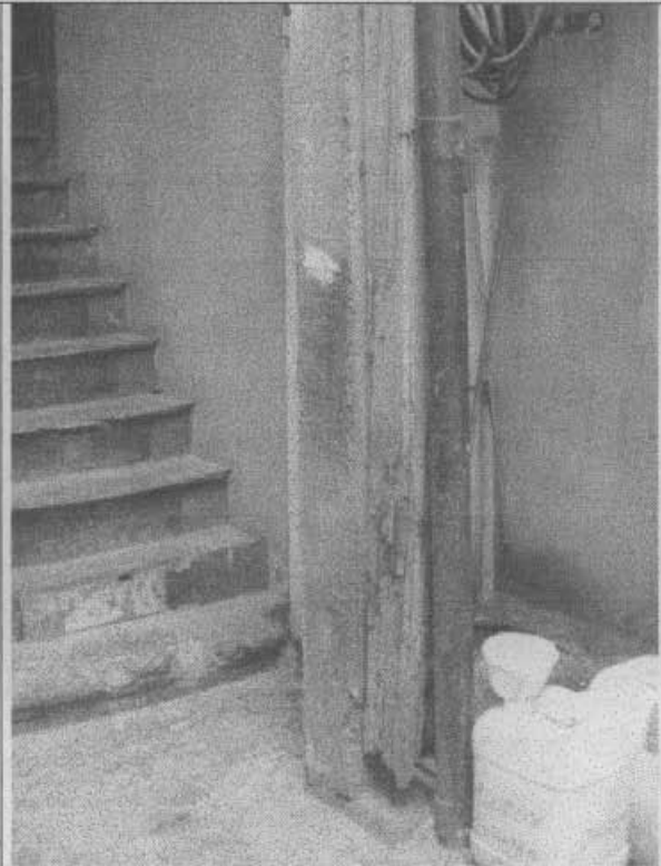
Foto 6. Columnas en madera descompuestas remplazadas por columnas de concreto.
